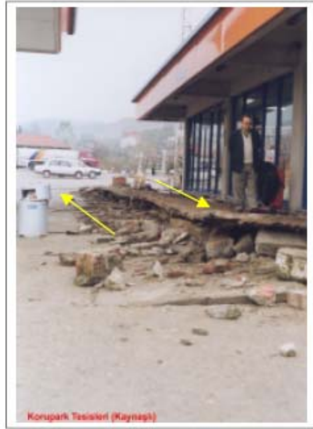
Şekil 6b. Korupark Dinlenme Tesisleri bahçesinde kademeli olarak gelişmiş ikincil yüzey kırıkları (Kaynaşlı).
