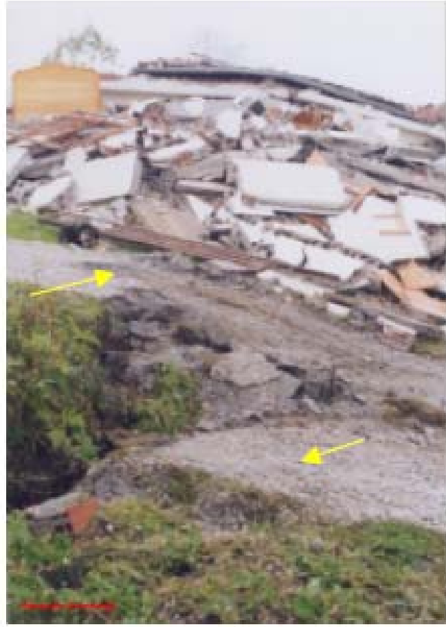
Şekil 6j. Faylanma sonucu tamamen yıkılmış bir yapı (Karaçalı Mah.-Kaynaşlı).
